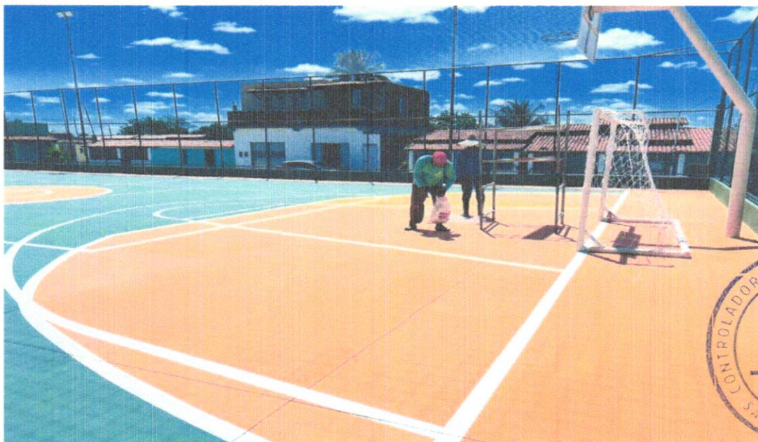
FOTO 02 – INSTALAÇÃO DE REDE PARA TRAVE DE FUTEBOL DE SALÃO (FUTSAL)
