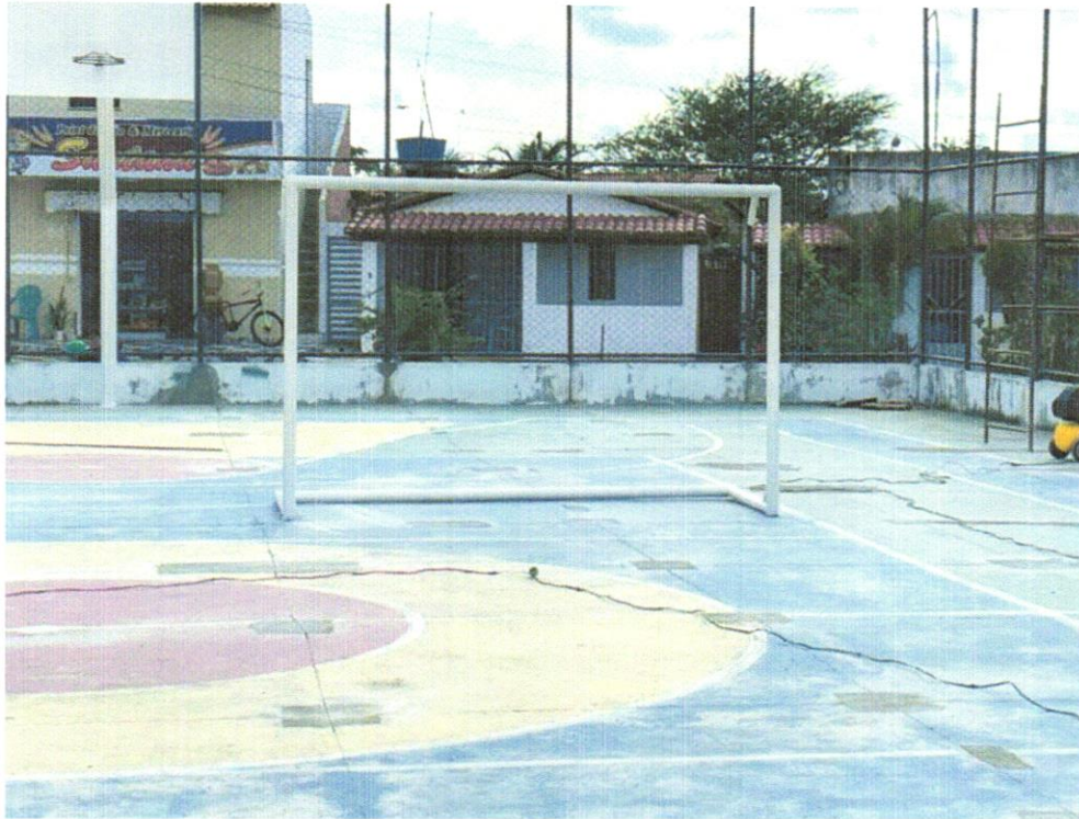
FOTO 17 – TRATAMENTO DE FISSURAS COM ARGAMASSA INDUSTRIALIZADA – MASSA RÁPIDA REBOTEC OU SIMILIAR (SEÇÃO ATÉ 5 X 5 CM)
