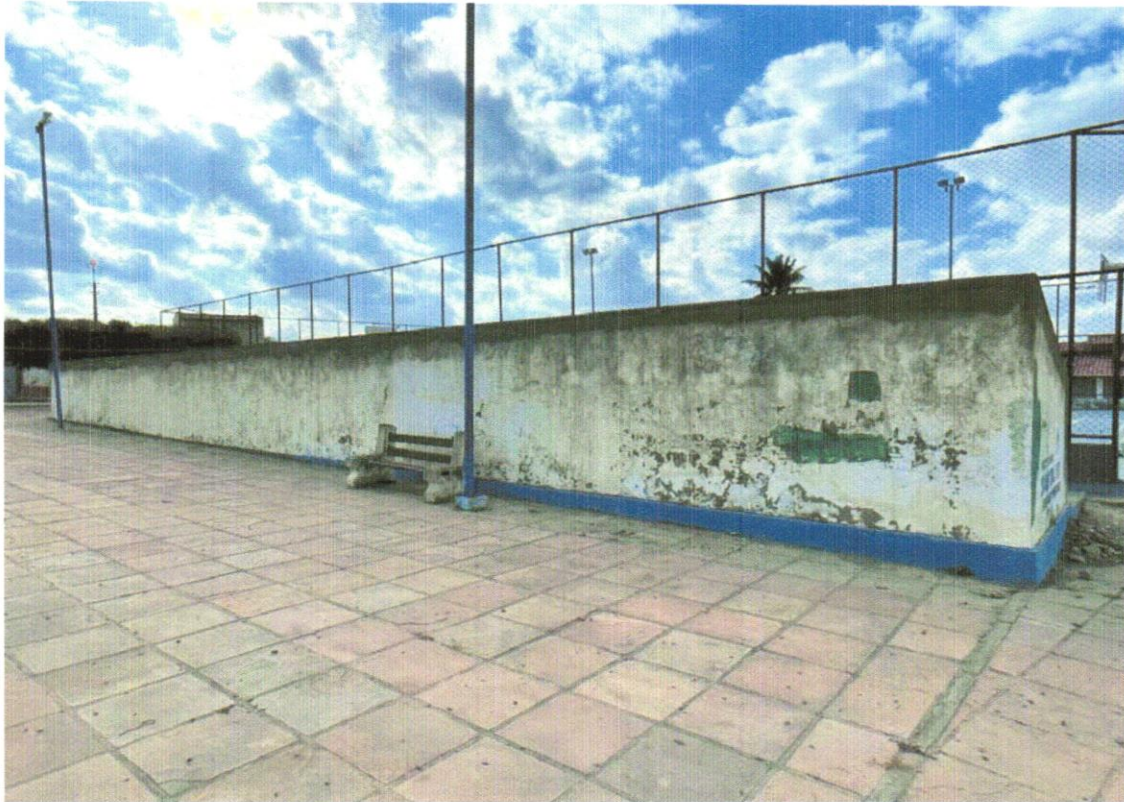
FOTO 19 – EMBOÇO OU MASSA ÚNICA EM ARGAMASSA TRAÇO 1:2:8, PREPARO MANUAL, APLICADA MANUALMENTE EM PANOS DE FACHADA COM PRESENÇA DE VÃOS, ESPESSURA DE 45 MM. AF_06/2014.
