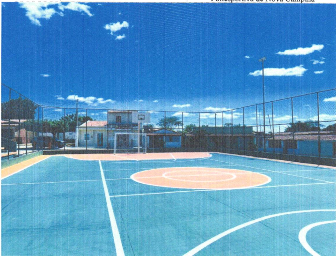
FOTO 01 – INSTALAÇÃO DE TELA DE PROTEÇÃO DE NYLON (3,6MM), MALHA 10X10CM
