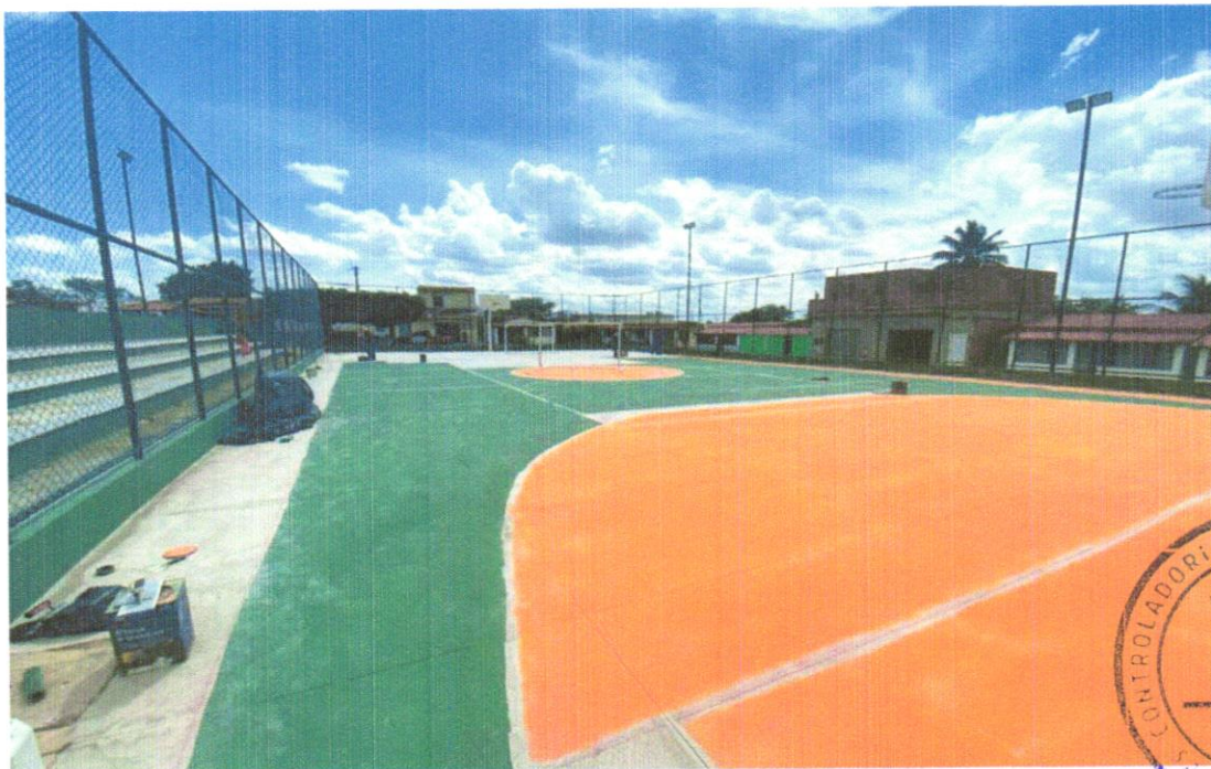
FOTO 08 - PINTURA DE ACABAMENTO COM APLICAÇÃO DE 02 DEMÃOS DE TINTA PVA LÁTEX PARA INTERIORES/EXTERIORES - CORES ESPECIAIS MISTURADAS EM MÁQUINA, TONS CLAROS (MARFIM,PÉROLA,ETC) - REV 01 - (COR VERDE)
