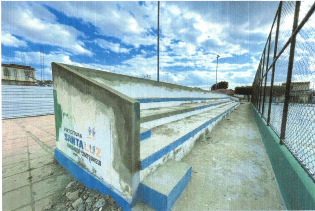
FOTO 07 - PISO CIMENTADO, TRAÇO 1:3 (CIMENTO E AREIA), ACABAMENTO LISO, ESPRESSURA 2,0 CM, PREPARO MECÂNICO DA ARGAMASSA AF_09/2020
