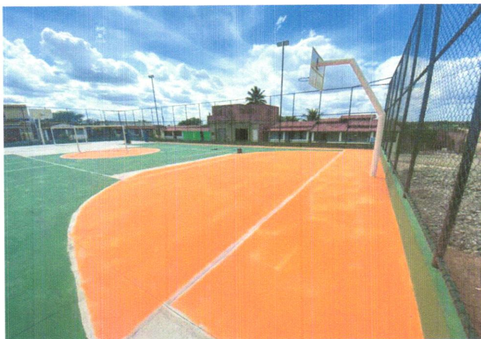
FOTO 10 – PINTURA DE ACABAMENTO COM APLICAÇÃO DE 02 DEMÃOS DE TINTA PVA LÁTEX PARA INTERIORES/EXTERIORES – CORES ESPECIAIS MISTURADAS EM MÁQUINA, TONS CLAROS (MARFIM,PÉROLA,ETC) – REV 01 – (COR LARANJA)
