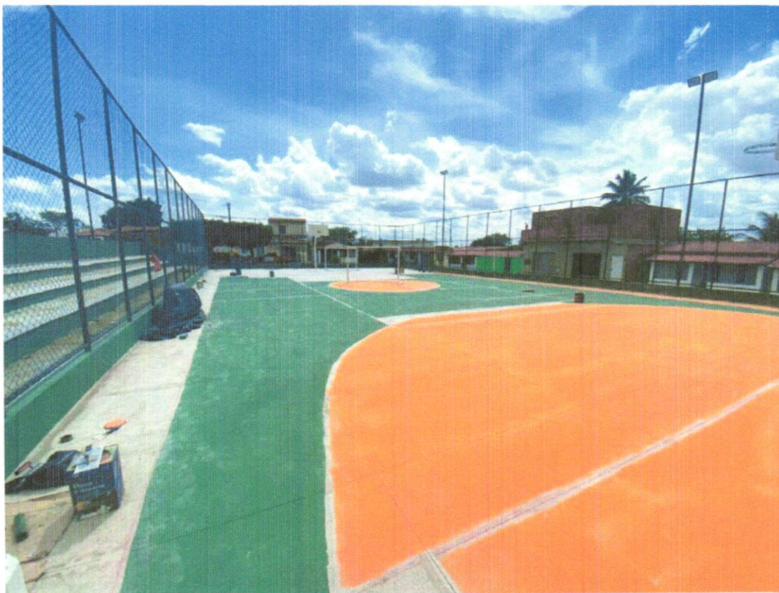
FOTO 11 – PINTURA DE ACABAMENTO COM APLICAÇÃO DE 02 DEMÃOS DE TINTA PVA LÁTEX PARA INTERIORES/EXTERIORES – CORES ESPECIAIS MISTURADAS EM MÁQUINA, TONS CLAROS (MARFIM,PÉROLA,ETC) – REV 01 – (COR LARANJA)
