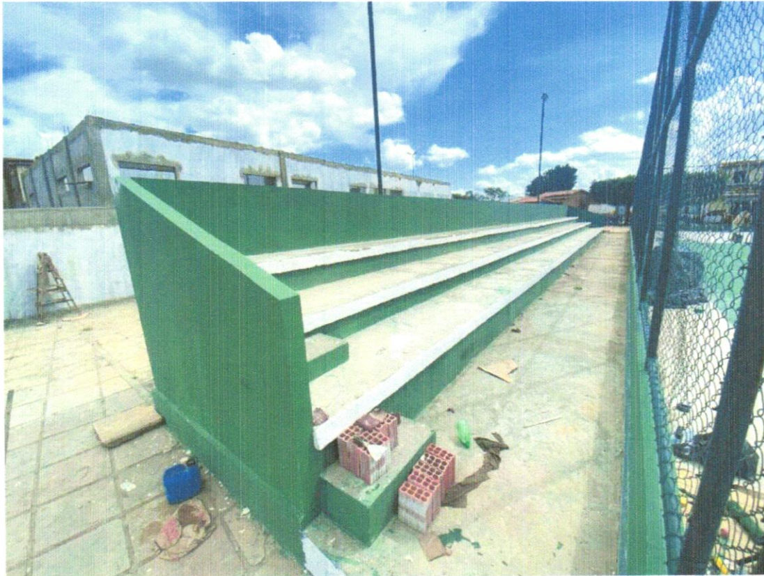
FOTO 15 – APLICAÇÃO MANUAL DE PINTURA COM TINTA LÁTEX ACRÍLICA EM PAREDES, DUAS DEMÃOS. AF_06/2014
