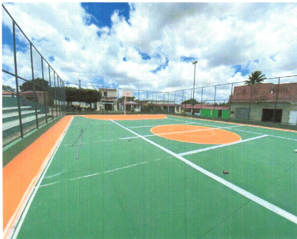
FOTO 09 – PINTURA DE ACABAMENTO COM APLICAÇÃO DE 02 DEMÃOS DE TINTA PVA LÁTEX PARA INTERIORES/EXTERIORES – CORES ESPECIAIS MISTURADAS EM MÁQUINA, TONS CLAROS (MARFIM,PÉROLA,ETC) – REV 01 – (COR VERDE)
