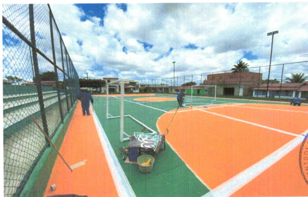
FOTO 12 – PINTURA DE ACABAMENTO COM APLICAÇÃO DE 02 DEMÃOS DE TINTA PVA LÁTEX PARA INTERIORES/EXTERIORES – CORES ESPECIAIS MISTURADAS EM MÁQUINA, TONS CLAROS (MARFIM,PÉROLA,ETC) – REV 01 – (COR BRANCA)
