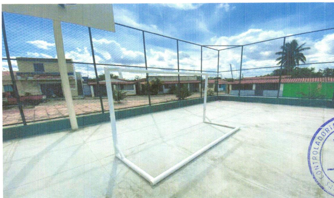
FOTO 04 – PINTURA ESMALTE EM ESTRUTURA METÁLICA, DUAS (2) DEMÃOS, INCLUSIVE, UMA DEMÃO DE FUNDO ANTICORROSIVO.
