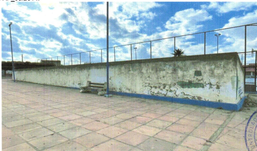
FOTO 20 – EMBOÇO OU MASSA ÚNICA EM ARGAMASSA TRAÇO 1:2:8, PREPARO MANUAL, APLICADA MANUALMENTE EM PANOS DE FACHADA COM PRESENÇA DE VÃOS, ESPESSURA DE 45 MM. AF_06/2014.
