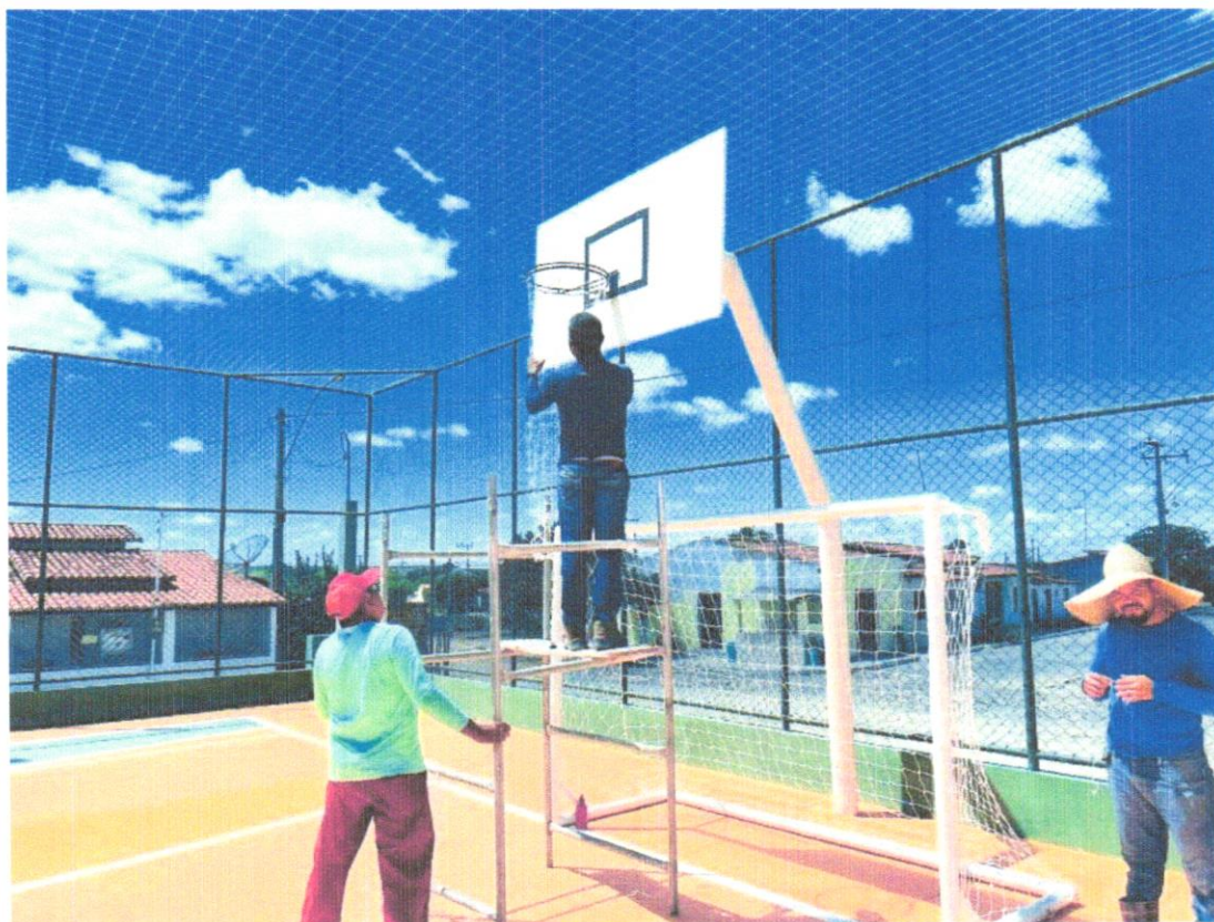
FOTO 05 - INSTALAÇÃO DE TABELA PARA BASQUETE OFICIAL EM LAMINADO NAVAL, MEDINDO 1,80 X1,20M, INCLUINDO, AROS FIXO METAL E REDES
